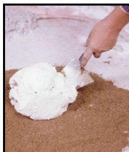
Chaux en pâte; mélange avec le granulat; remarquer la plasticité de la préparation
