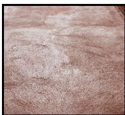
Brillance d'un enduit teinté dans la masse
