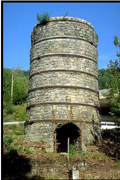
Four à chaux (Jura)
